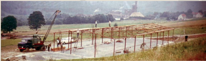
Baubeginn 1971 in Brumlingsen, im Hintergrund die alte Zellstofffabrik in Wildshausen
